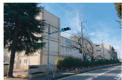
建て替え予定の校舎
